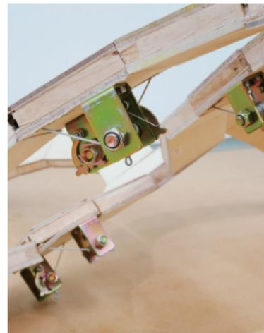
今回のモックアップでは、テンション材にワイヤーを用いている。段階的にテンションをかけられるようラチェットタイプの巻き取り金物を用いている。モックアップでの失敗として、
